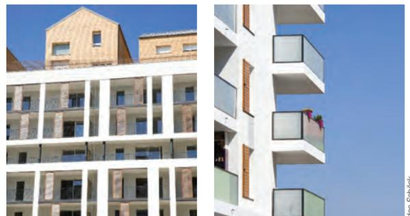
▲ Le rupteur de ponts thermiques Schöck Rutherma® assure la continuité de l'isolation tout en reprenant les sollicitations de structure, en isolation extérieure, répartie ou intérieure pour tous les éléments saillants du bâtiment. Pour le projet de Limeil-Brévannes, 760 mètres de rupteurs Schöck Rutherma modèle DF ont été posés. Réduction immédiate et optimale des déperditions énergétiques garantie.
