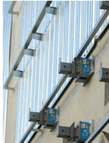
▲ Sur le chantier du Musée de la Romanité à Nîmes, 200 rupteurs KST 16 standard et 40 KST 16 spécial (longueur tige filetée 145 MM) ont été posés. Les rupteurs vont permettre d'éviter les ponts thermiques entre la structure béton et la façade rapportée en verre.
